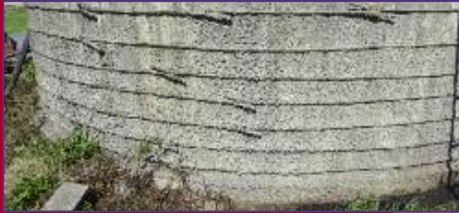
Rénovation d'un bas de silo endommagé
