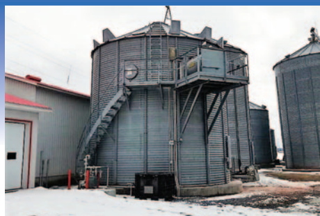
Silo Top-Dry , 24-06 GSI, brûleur 42 po, 10-16 hp, L.P., 220 volts
