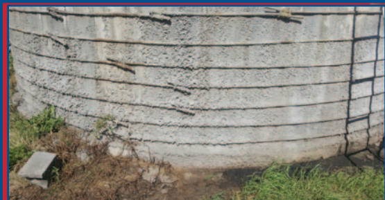
Rénovation d'un bas de silo endommagé
