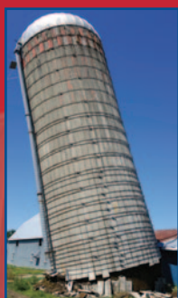
Rénovation d'un bas de silo endommagé
