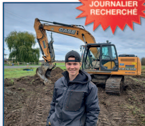
Raphaël Blouin Opérateur d'excavatrice
