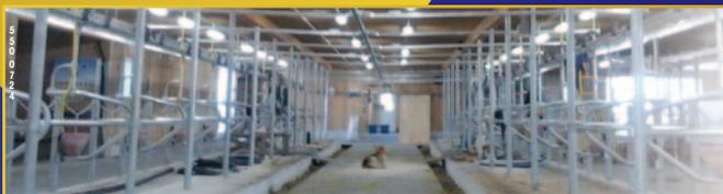
Rails en acier galvanisé et barrières multitâches en aluminium.
