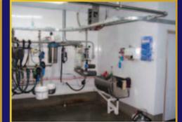
Porteur à eau au poste de lavage dans la laiterie avec plaque pour balance Watake
