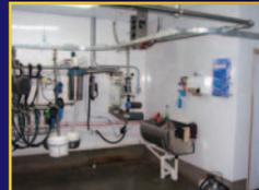
Porteur à eau au poste de lavage dans la laiterie avec plaque pour balance Watake
