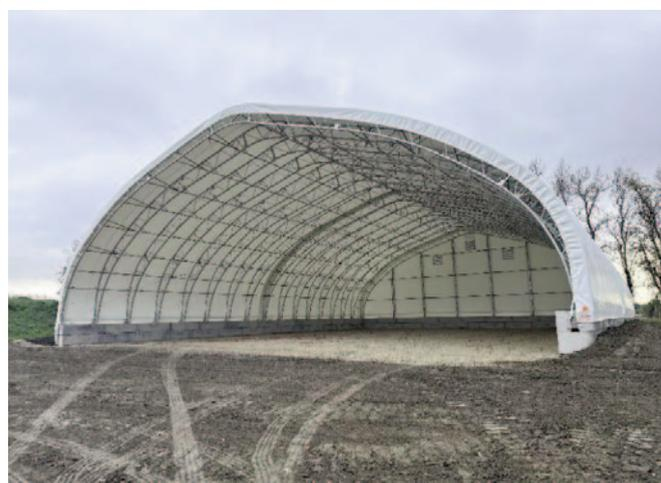
Système de blocs Multi-Lock pour murs, enclos et fondations de dômes
